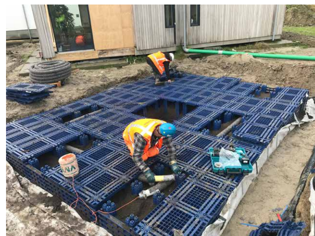
De afdichtende platen op de TreeTank-units zijn stevig genoeg om een parkeervak van straatklinkers te kunnen dragen met daarop een geparkeerde auto.
