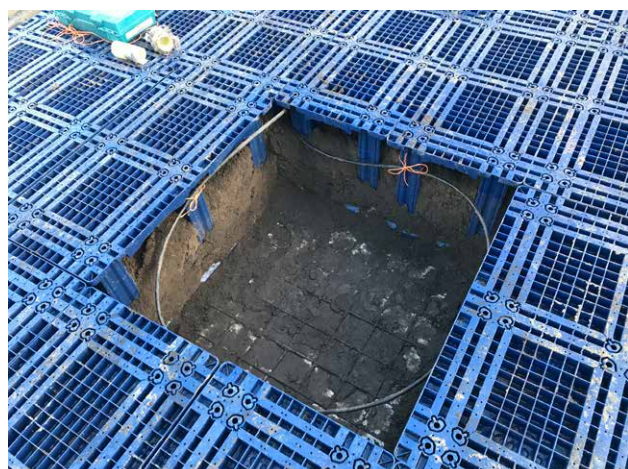
In het hart van de installatie is een plantgat uitgespaard, waarin een boom ongestoord kan wortelen en voorzien wordt van opgevangen regenwater, zuurstof en voedingsstoffen.
