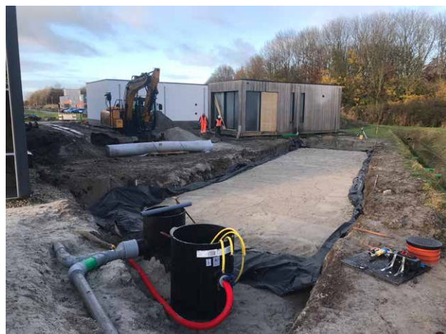
De TreeTank installatie rust op een geëgaliseerd stuk grond.
