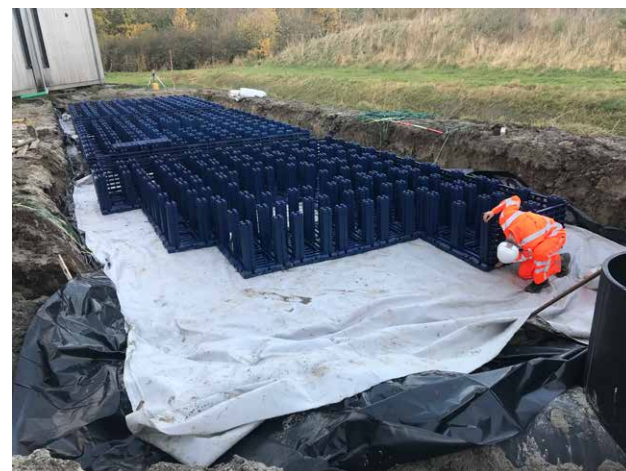
De TreeTank-units van blauwe circulaire kunststof laten zich installeren alsof het Legoblokken zijn.
