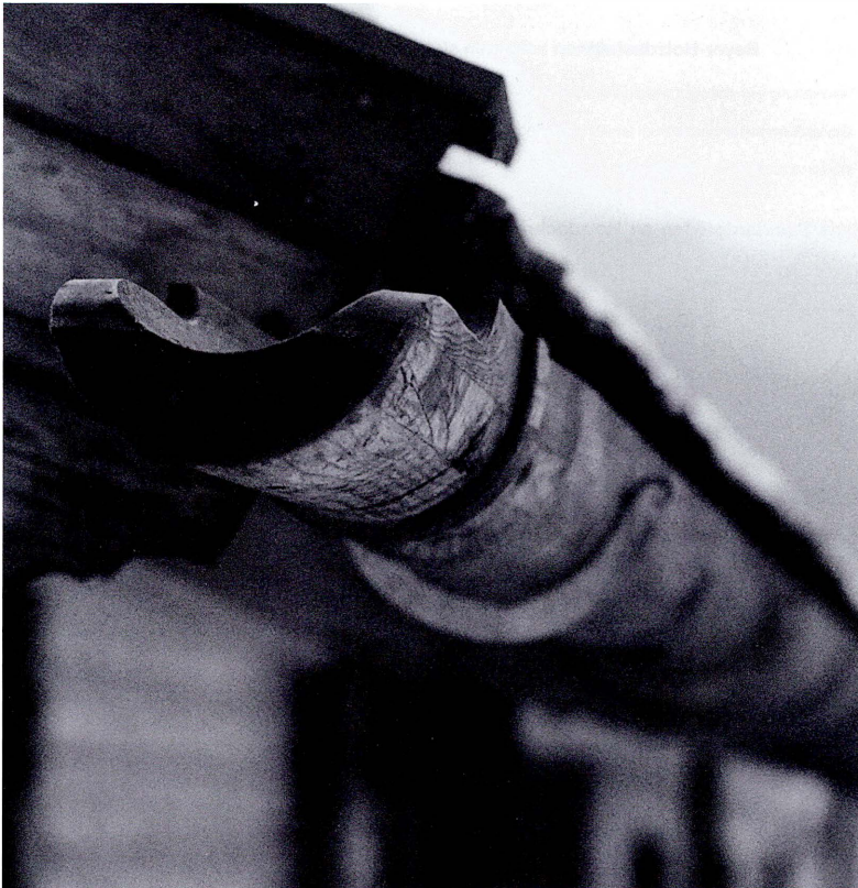
In een project in Roosendaal zijn dakgoten toegepast van lokaal gewonnen lariks. Architect: Jaap van der Laan, Haastrecht.
