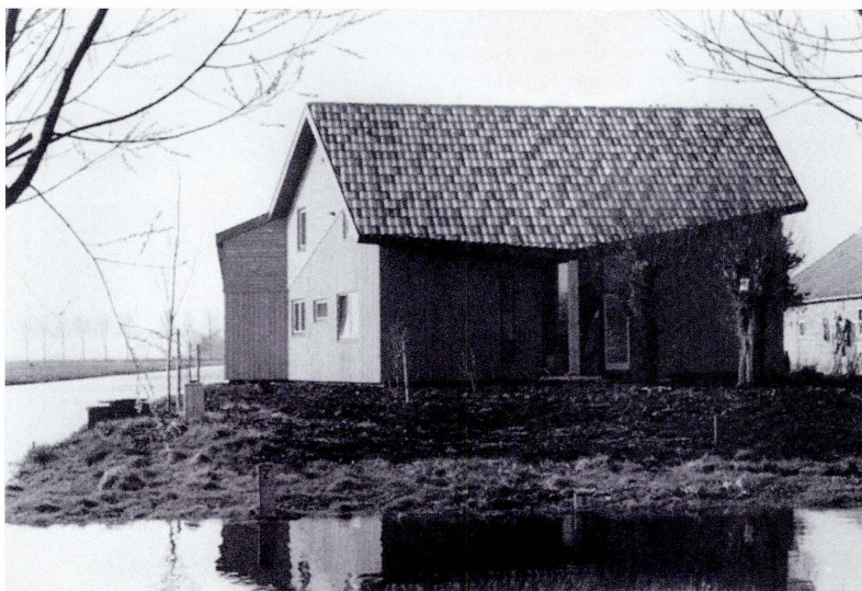
Vuren in de gevel kan worden afgewerkt met weinig milieubelastende kookverf, zoals in dit project te Bergambacht (ZH). Architect: Jaap van der Laan, Haastrecht (ZH).
