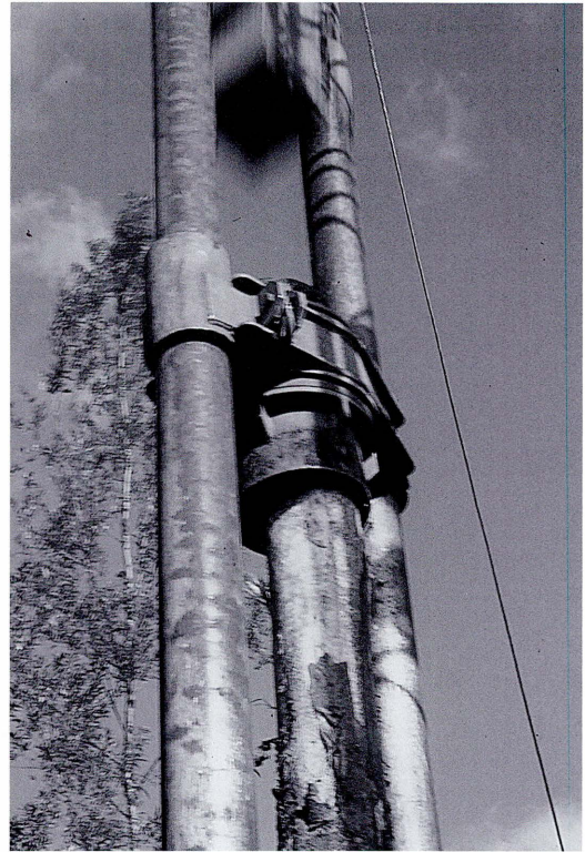
Douglas wordt, evenals vuren (fijnspar) en lariks, in Nederland gebruikt als heipaal maar verdient eigenlijk beter.
