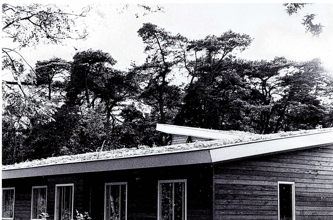
Lariks kan onverduurzaam in de gevel worden toegepast zoals in dit project in de bossen bij Baarn. Architect: BEAR, Gouda.
