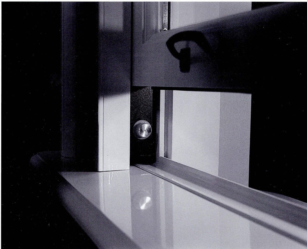
Tamme kastanjehout van dertig jaar en ouder kan prima worden toegepast als raam- en kozijnhout, bijvoorbeeld voor schuiframen.
