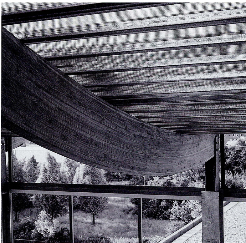
Gelamineerde, gekromde liggers dragen het dak van de agarische school.
