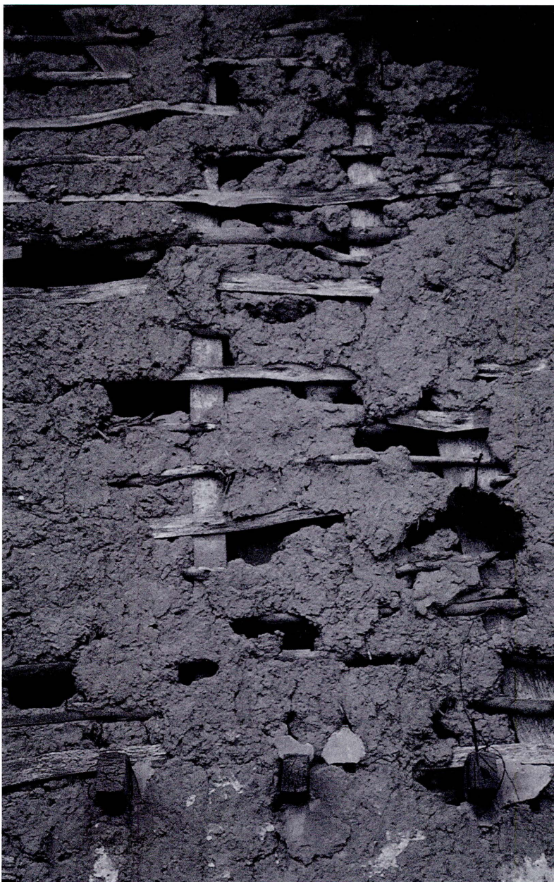
Oud wilgenvlechtwerk met resten leem.
