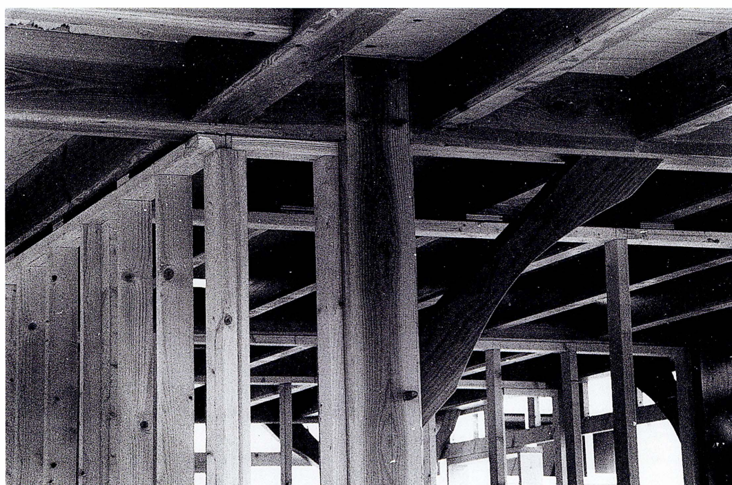
Boven: Woning te Emmeloord. Douglas verbonden met eiken deuvels. De gehele constructie is demontabel. Onder: De robuuste douglasconstructie blijft geheel in het zicht.
