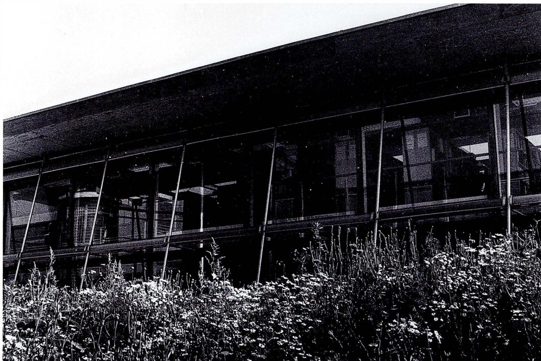
Gelamineerd robinia is toegepast in de gevel van het Instituut voor Bos en Natuuronderzoek te Wageningen.
