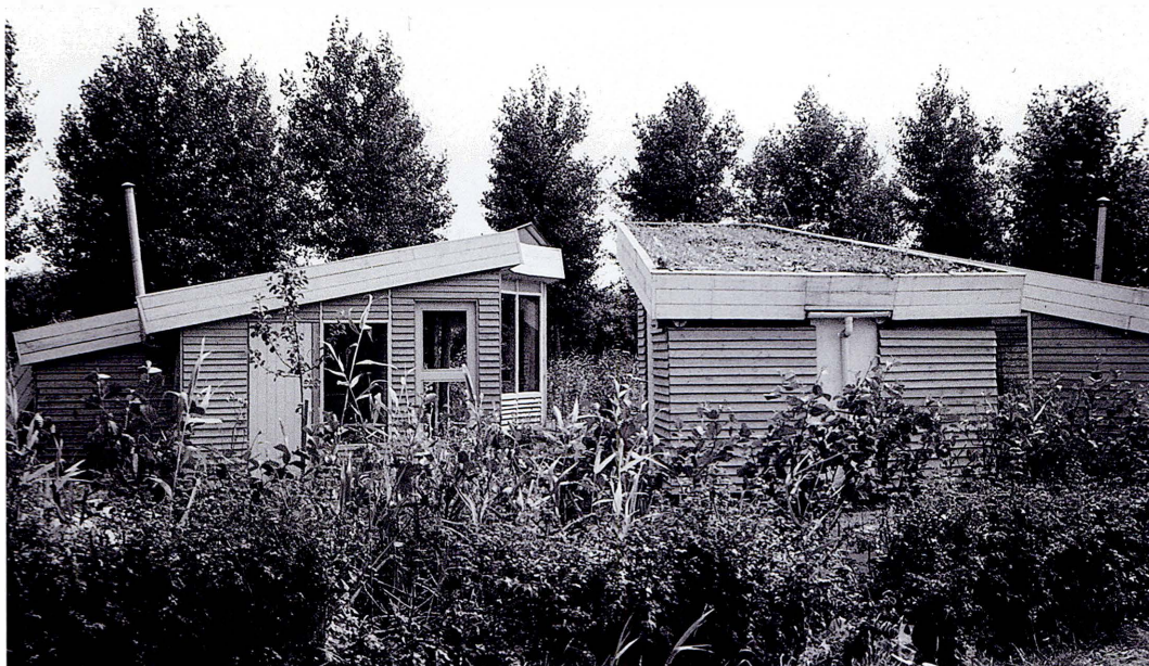
Populieren wordt vaak als (eenmalig te gebruiken) pallet hout toegepast. In Almere staat een atelierwoning waarvan de gevel is met oud pallet hout is gepotdekseld en daarna afgewerkt met kookverf. Architect: R.J. Wijnjtes, Hoorn.
