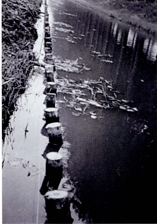
Tamme kastanje palen met wilgenrijshout vormen een milieuvriendelijke oeverbeschoeiing.
