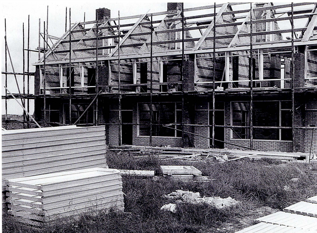
Vuren is verreweg het meest universele bouwhout; het kan worden toegepast als kozijn, als vloerbalk en -plank, als dakbeschoot, voor gordingen, als triplex, als steigerhout enzovoorts.
