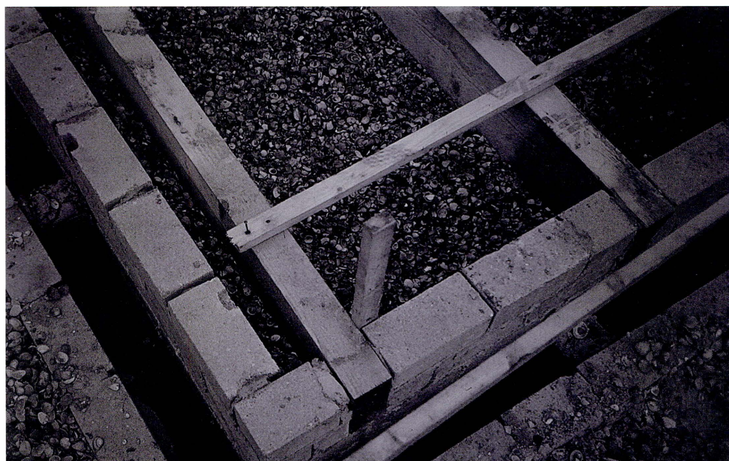
Vuren balken boven een dikke laag vochtwerende schelpen.
