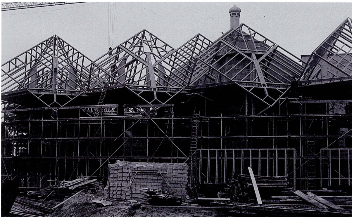
Vuren leent zich voor allerlei vormen.... ...die in hoge mate geprefabriceerd kunnen worden. Architect: Piet Blom.
