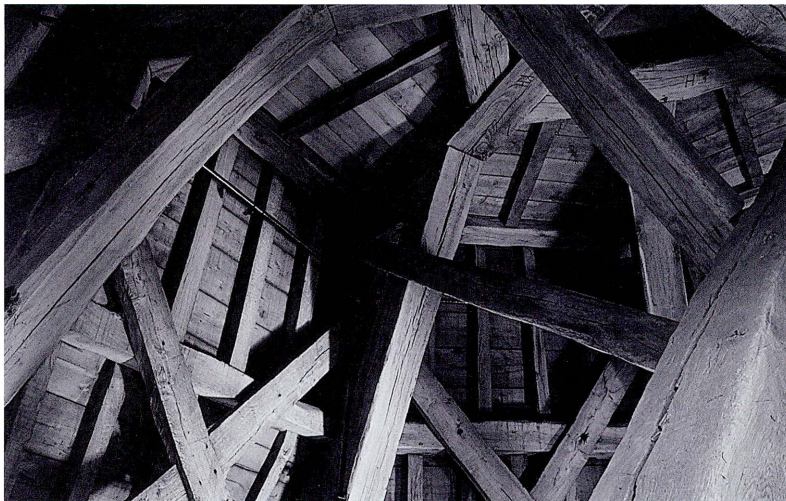
Eiken vakwerkconstructie in de toren van Hilvarenbeek.
