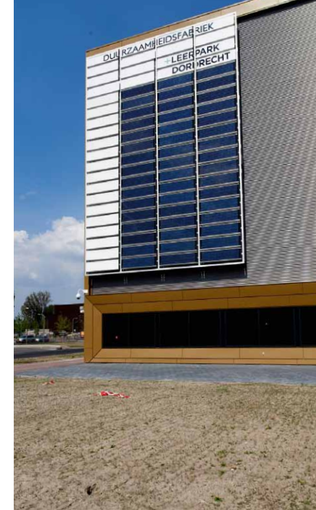
De gevel van de Duurzaamheidsfabriek, met 4-D panelen: "De panelen kunnen draaien en zijn soms zonnepaneel, soms wateropvang, soms afvang van stikstof en soms reclamezuil."
