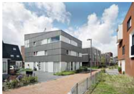
De Bongerd kent een ruime variatie aan woningen: het ontwerp 'Otava' van architect Paul de Ruiter kent zelfs een gevelbeplating van aluminium.
