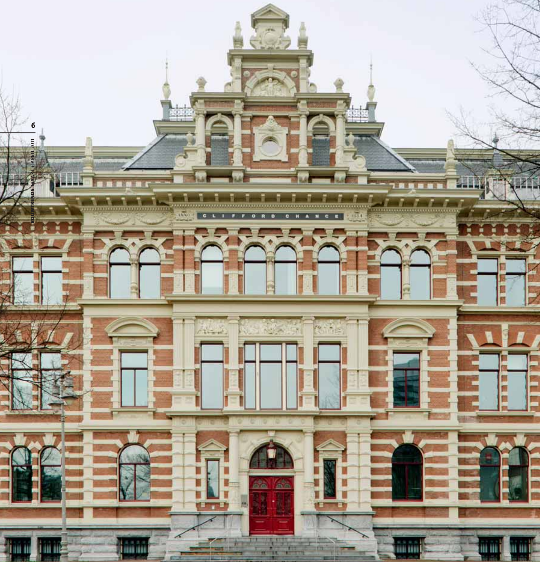
Het monumentale pand aan de Droogbak in het centrum van Amsterdam, pal naast het Centraal Station. Gebouwd in 1882 tot 1884, op 2.700 scheepsmasten, in opdracht van de Hollandsche IJzeren Spoorweg Maatschappij, een voorloper van de NS. Het kantoor herbergt iets meer dan 350 werknemers.
